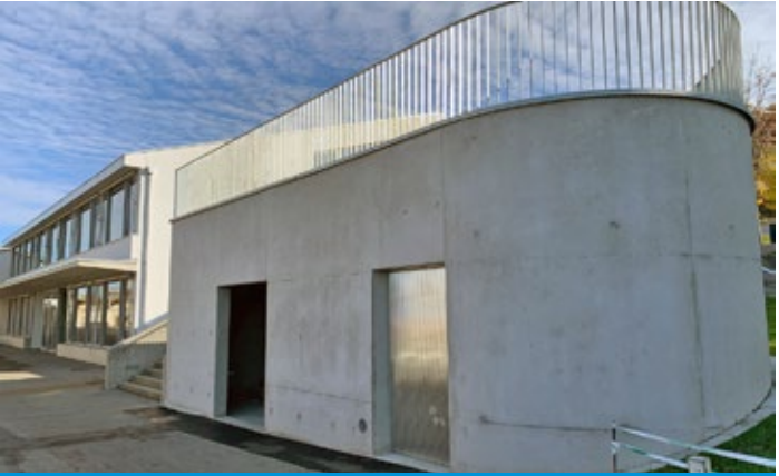
MAIHOF AREAL SCHINDELLEGI
